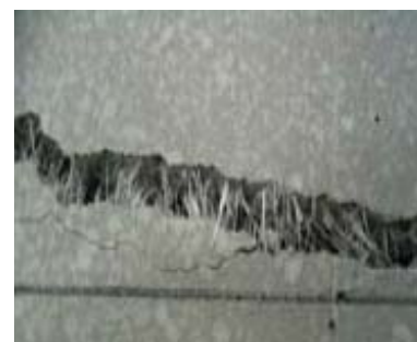
曲げ試験体のひび割れ面 (繊維による引張抵抗)
