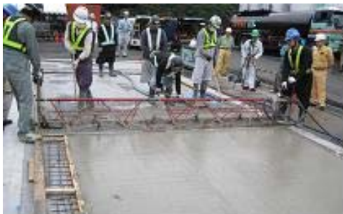
簡易フィニッシャー稼動状況
