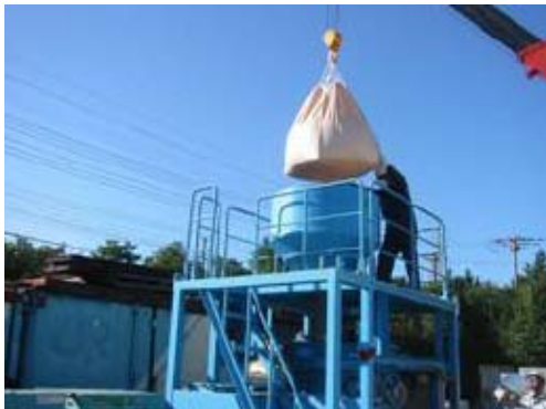
試験施工での練混ぜ状況とグラウトミキサー
