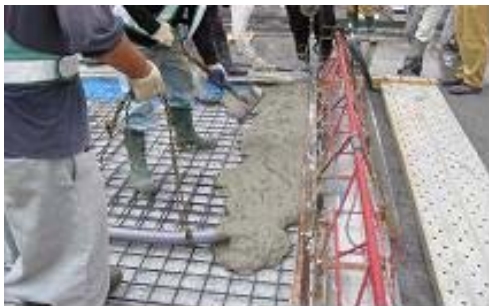
超速硬型高靱性モルタル打込み状況(1)
