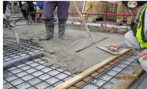
超速硬型高靱性モルタル打込み状況(2)
