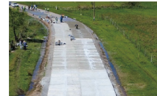
バルチップを使用したコンクリート道路
